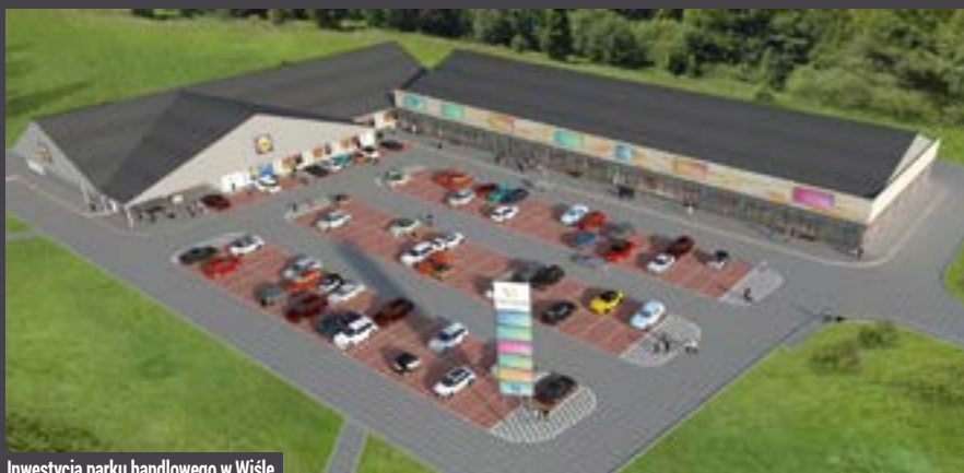
Inwestycja parku handlowego w Wiśle
