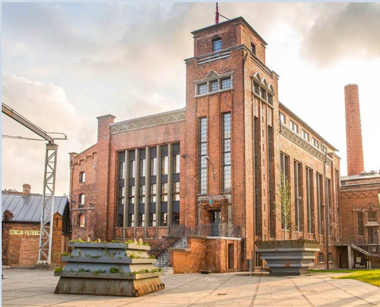
Cukrownia Żnin zaadaptowana na Arche Hotel
