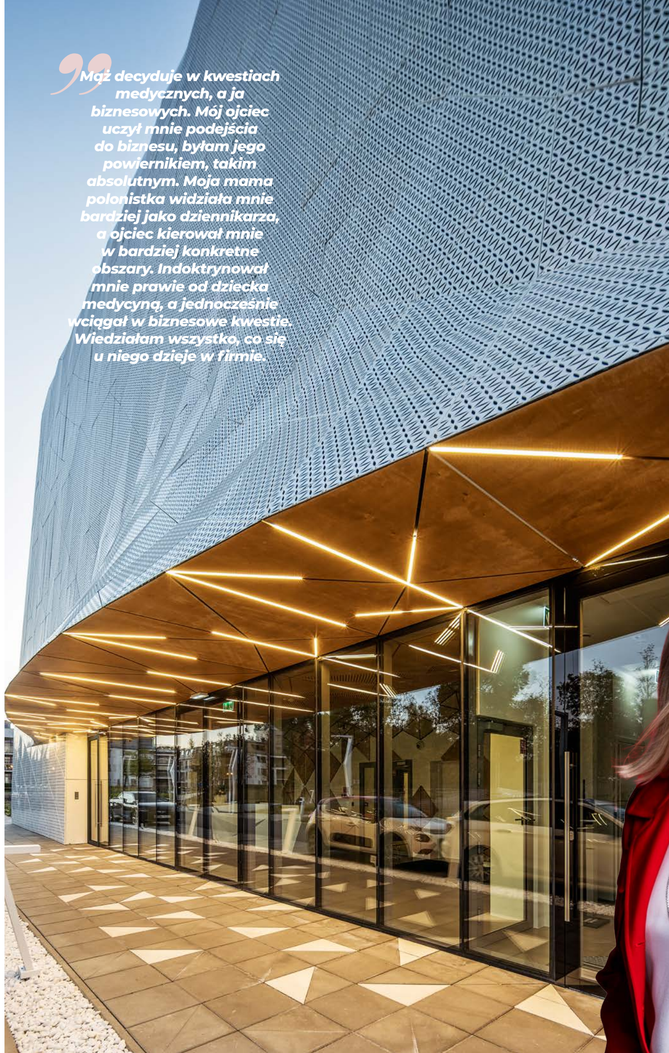
ECP Sopot budynek B1
