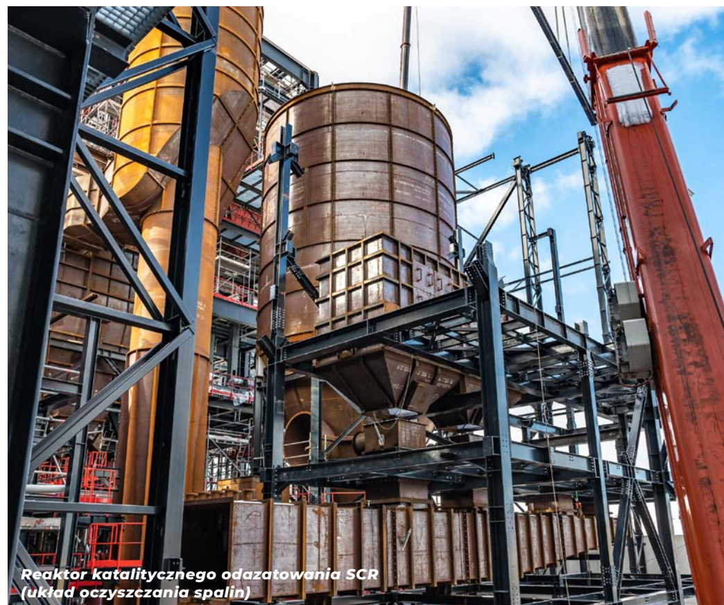
Prace na budowie - październik 2021
